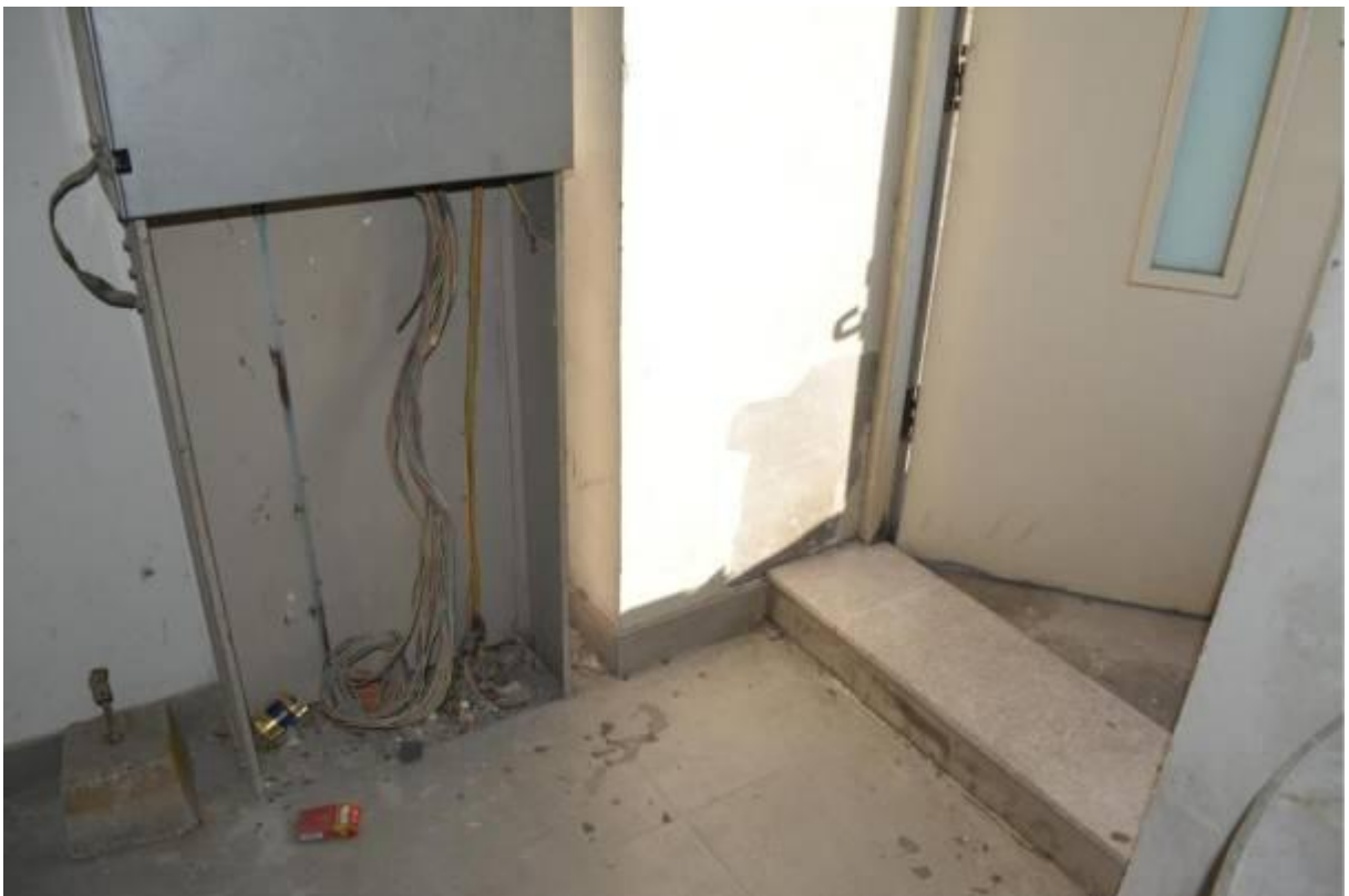
7号楼楼顶地面发现烟盒
