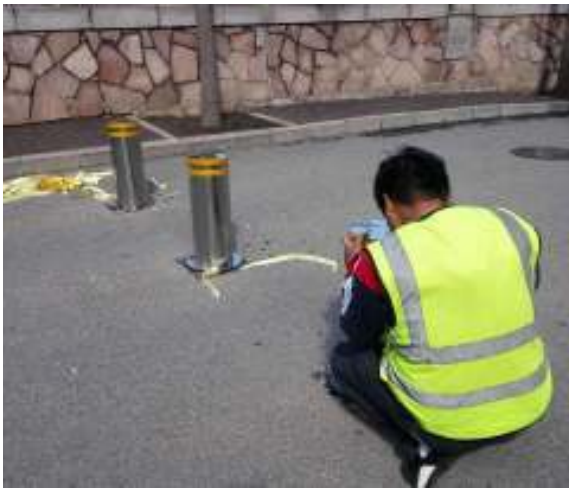
养护交通设施
